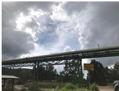
Gambar 6 Area yang sudah dipasang Conveyor Belt Hood. (Sumber: Dokumentasi Lapangan, 2020)
