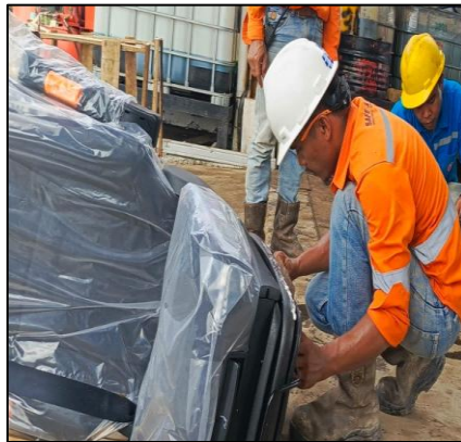
Gambar 17 Penggantian Kursi unit DT oleh Departement Plant
