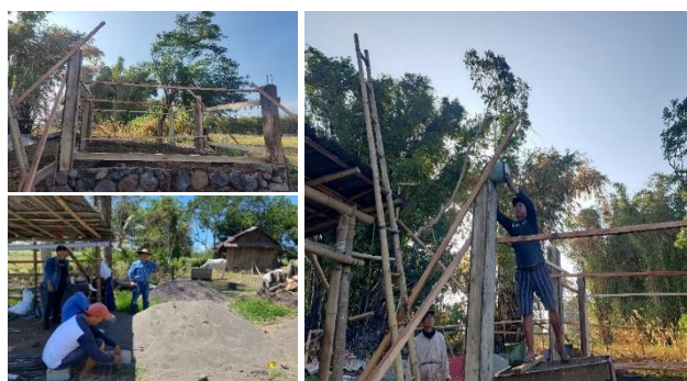
Gambar 4. Pembuatan Kandang Ternak Sapi
