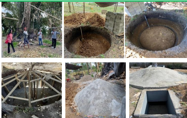
Gambar 5. Proses Pembuatan Reaktor Biogas di Lokasi Mitra
