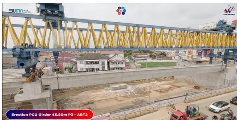
Gambar 18. Perletakan Ke Bearing Pad
