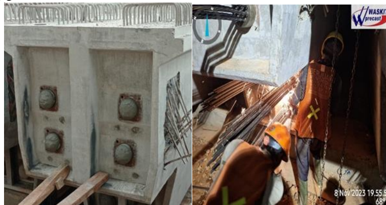
Gambar 14. Pemotongan Kabel Strand dan Patching Tendon
